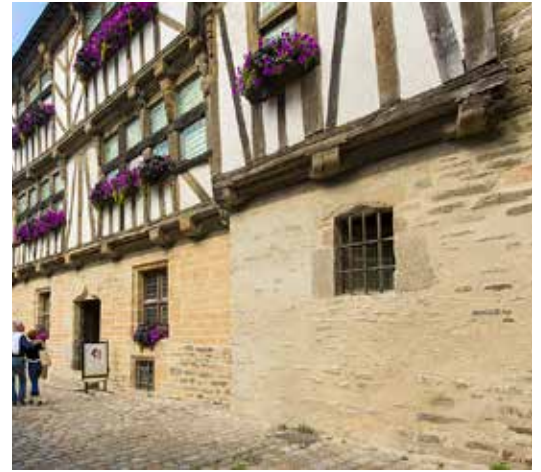
Maison des Archers à Quimperlé
